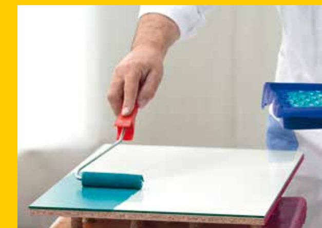
Schritt 2: Lack mit einem Roller auftragen.
