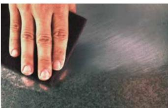
Verzinkte Flächen und Aluminium entfetten Sie mit dem ADLER Entfetter und Scheifvlies. Damit schleifen Sie die Oberfläche gleichzeitig an. So kann der Lack gut haften.
